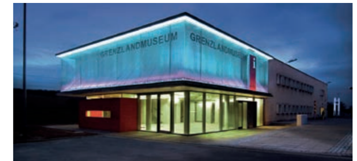
Ansicht in der Nacht mit hinterleuchtetem Drahtgewebe.
