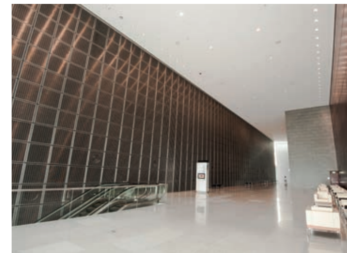
Gewebekassetten aus HAVER Architekturgewebe. Qatar National Convention Center, Doha, Katar.
