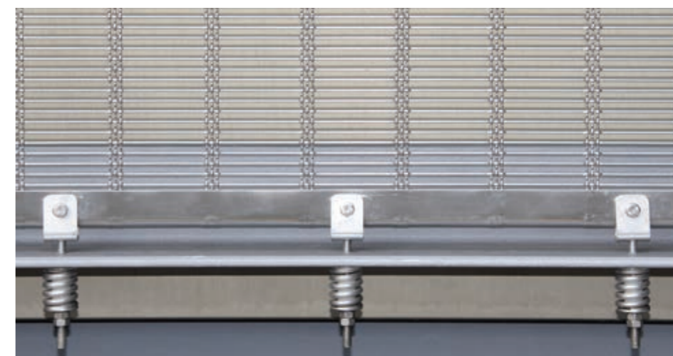
Untere Befestigung: Spannkante, Gabelschraube und Druckfeder.
