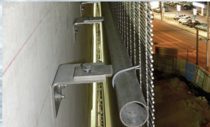
Zwischenbefestigung: Rundrohr und Drahtsicherung.
