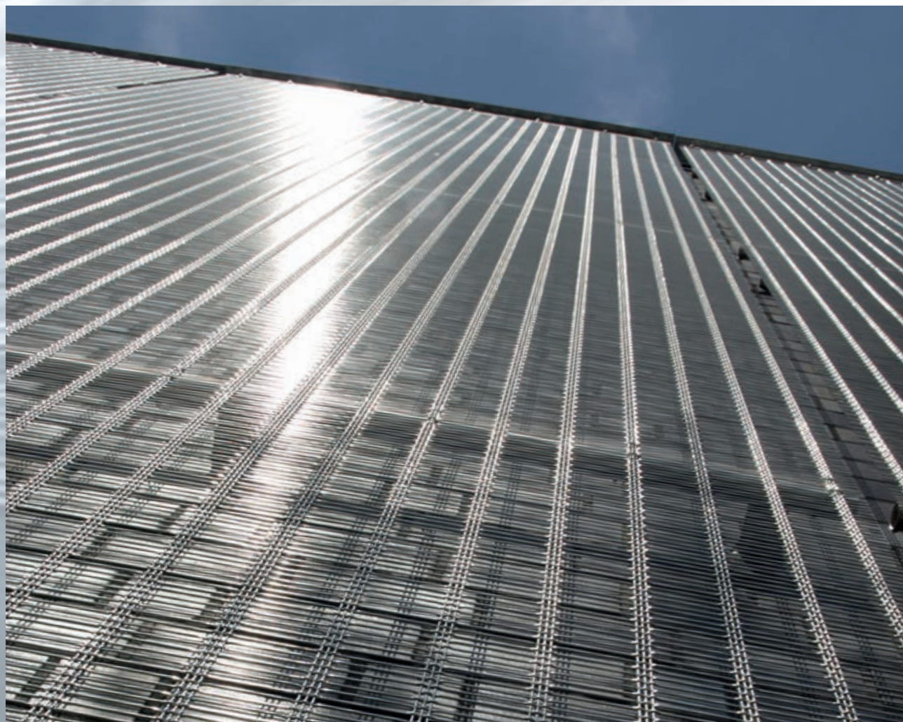
Architekturgewebe können über mehrere Geschosse hinweg vertikal gespannt werden. Tragende Unterkonstruktionen sind lediglich an der oberen und unteren Stirnseite erforderlich.
