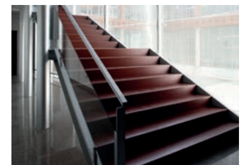
Die Kombination von Transparenz und Sonnenschutz ist ideal für die moderne Glasarchitektur.
