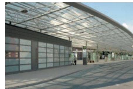
Drahtgewebe als Sonnenschutz. Busbahnhof Herne, Deutschland.
