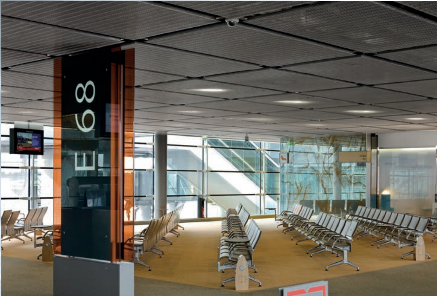
Architekturgewebe gewährt optimale Funktion von Lüftungs- oder Sprinkleranlagen. Terminal S3, Flughafen Roissy Charles de Gaulle, Paris, Frankreich.
