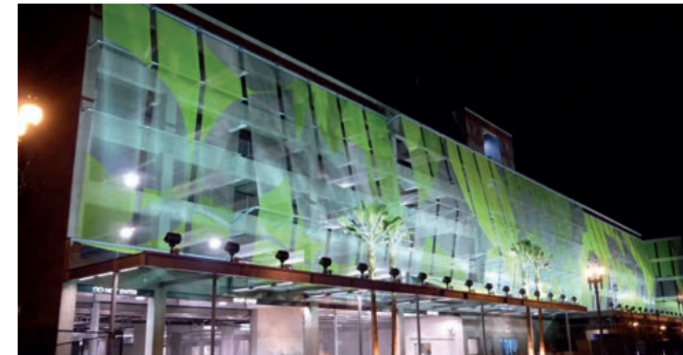
Partiell lackierte Gewebefassaden. Parkhaus Los Angeles Police Department, USA.
