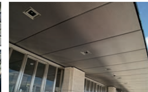
Deckenverkleidung aus Rahmenelementen. Stadion Krasnodar, Russland.
