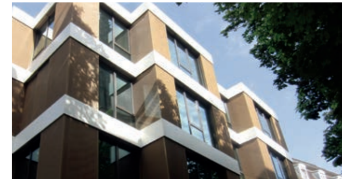
Aus Alt wird Neu. Fassadenverkleidung mit HAVER Architekturgewebe am Kongresshaus Baden-Baden, Deutschland.
