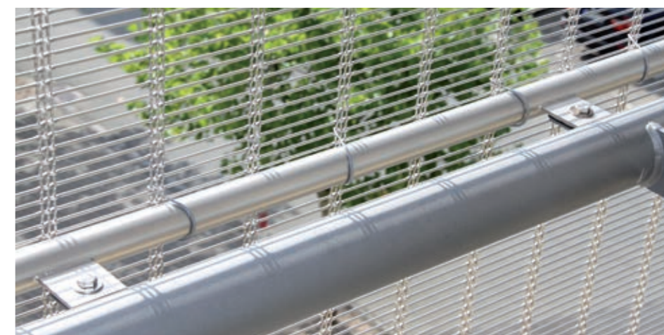
Zwischenbefestigung: Rundrohr und Drahtsicherung.
