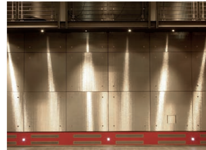
Architekturgewebe lässt die Wände des Proszeniums im Théâtre Municipal in Luxemburg erstrahlen.
