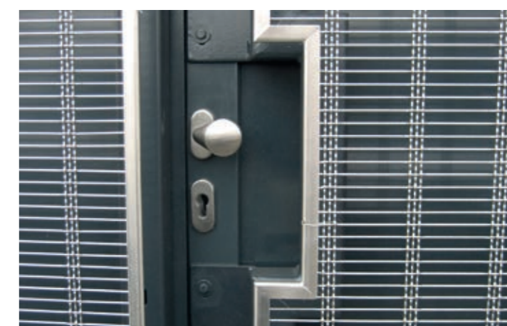
Gewebe-Einfassung mit Kantenschutzprofilen.
