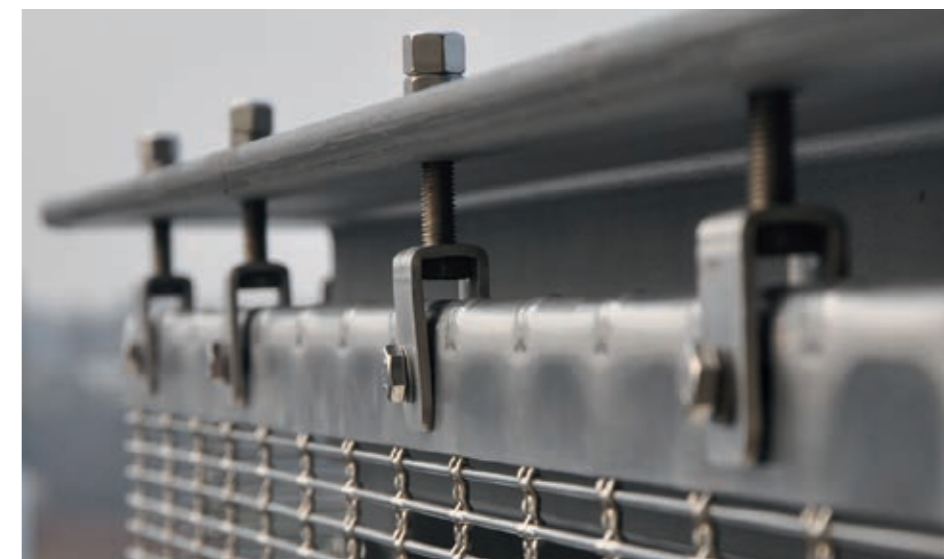
Obere Befestigung: Spannkante und Gabelschraube.
