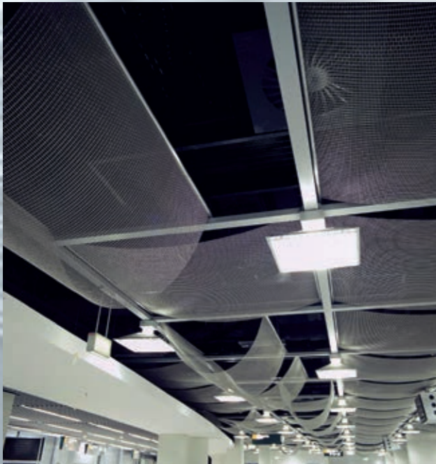
Revisionierbares Befestigungssystem für Decken mit Durchhang.
