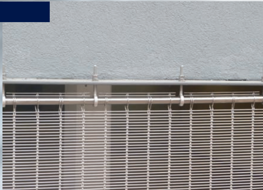
Obere Befestigung: Rundstab mit Augenschrauben.
